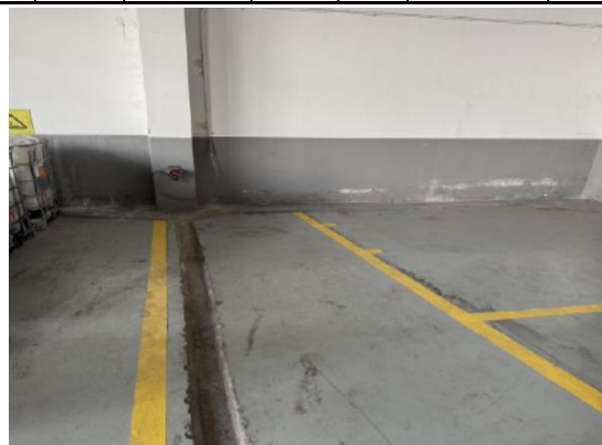
危废暂存设施
